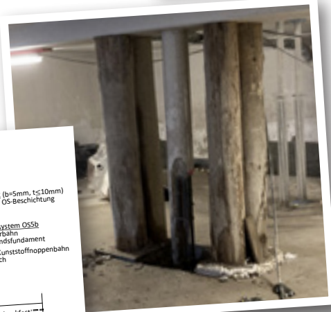
Die Lochfraß-Korrosion in der Stützenbewehrung in Folge des Chlorid-Eintrags im Beton wird erst nach dem Betonabtrag erkennbar.
