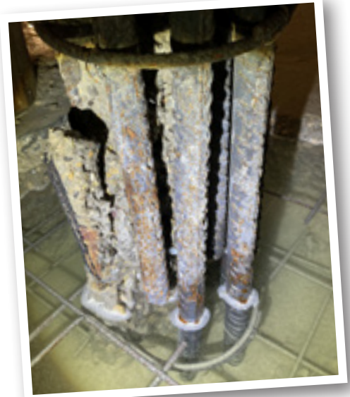
Die Lochfraß-Korrosion in der Stützenbewehrung in Folge des Chlorid-Eintrags im Beton wird erst nach dem Betonabtrag erkennbar.
